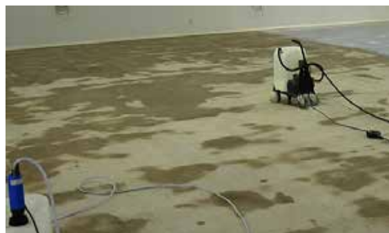
Vattning av betonggolv.
